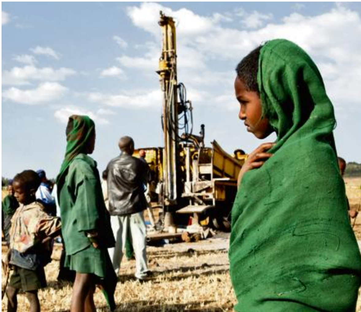
Forage d'un puits financé par l'Unicef en Somalie. Photo Barbara Dombrowski/LAIF-REA
